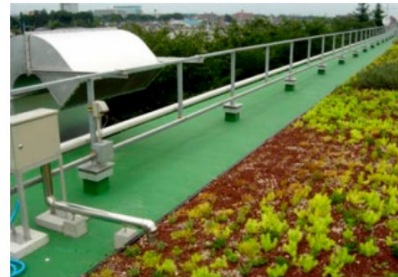
排気口からの熱風による衰退事例
